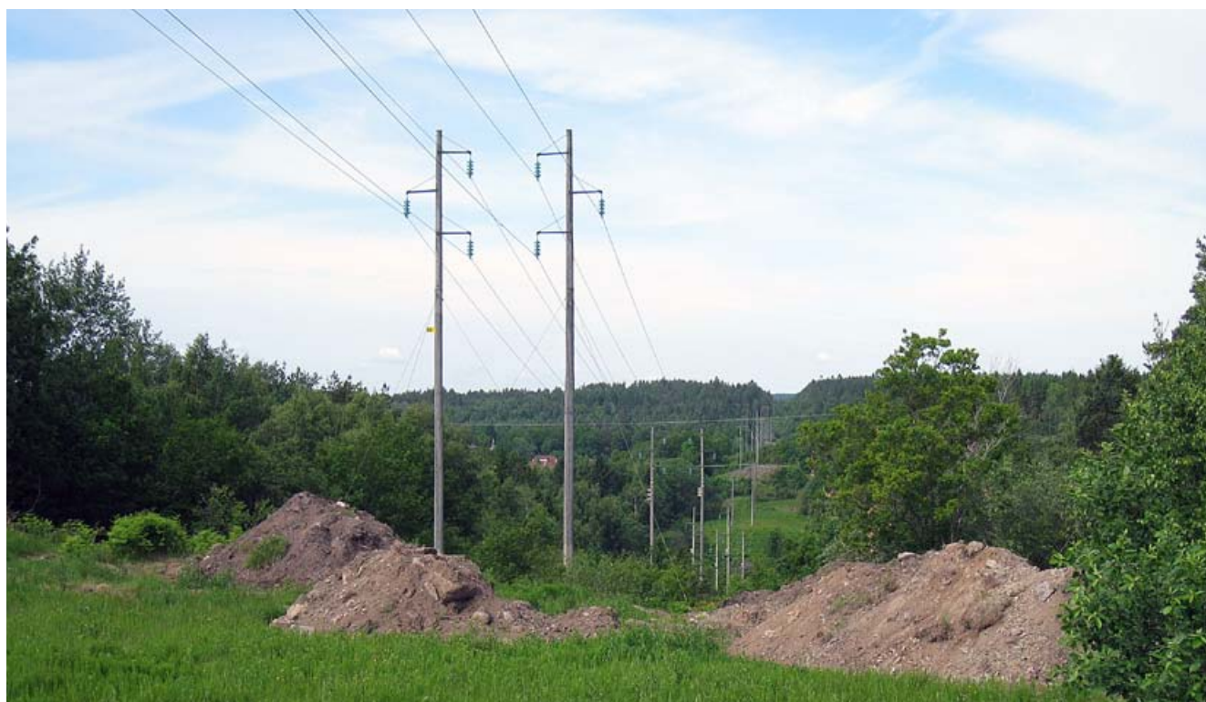
Vi har grävt ner mer än 10 mil kabel sedan 2005.
